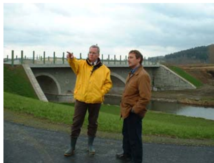
Straßenbauamtsleiter Petzold und Rolf Schwanitz bei der Baustellenbegehung
