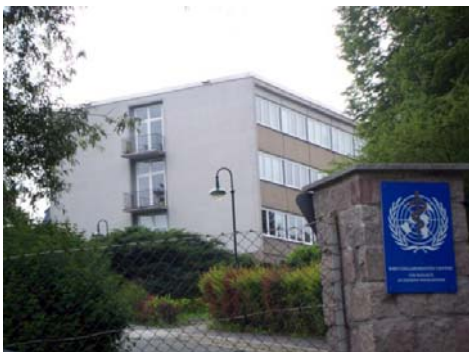
Das Dienstgebäude des Umweltbundesamtes in Bad Elster
